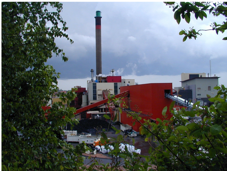
Photo 4 : Installation d'incinération des ordures ménagères
